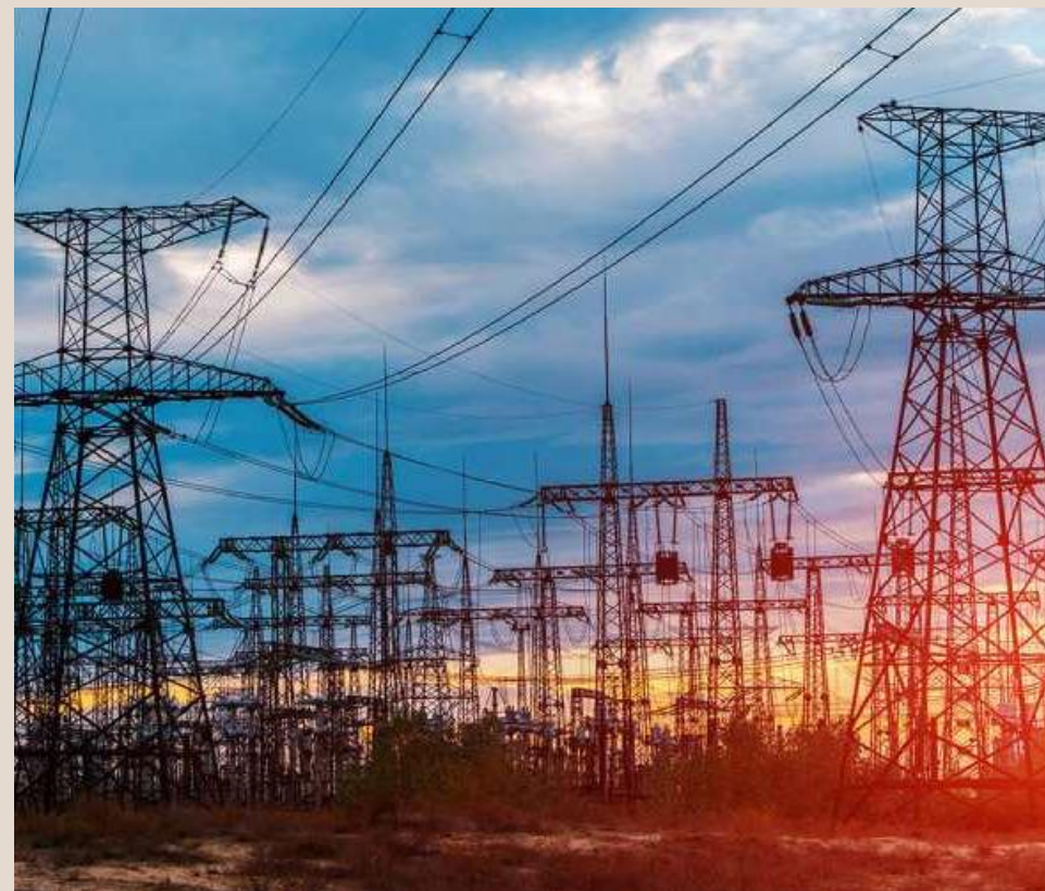
Descarbonizar la red eléctrica.
