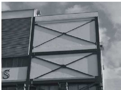
Figura 38: Arriostramiento sin exposición al fuego (VARGAS; SILVA, 2003)
