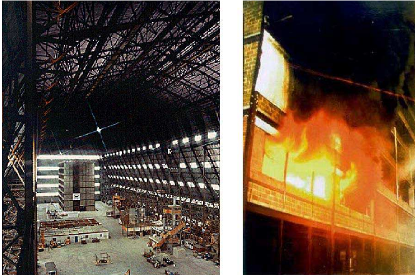
Figura 33 – Edificio incendiado en Cardington Foto SCI
