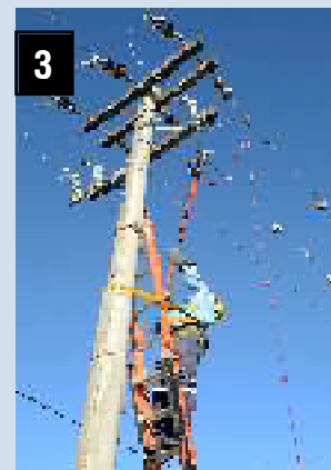
1. Verificación del buen contacto de los morsetos / 2. El carretel del cable de la puesta a tierra debe estar absolutamente desarrollado / 3. El cable debe estar separado del cuerpo del operario.
