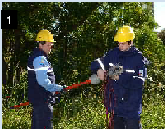
1. Verificación del buen contacto de los morsetos / 2. El carretel del cable de la puesta a tierra debe estar absolutamente desarrollado / 3. El cable debe estar separado del cuerpo del operario.
