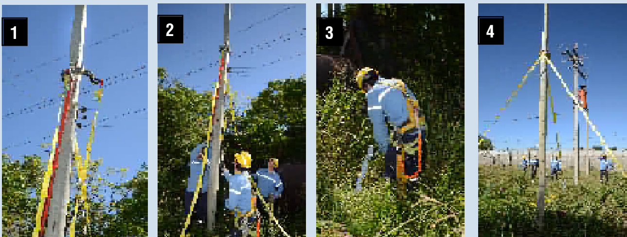
Serie fotográfica ilustrativa del correcto proceso de arriostramiento.
