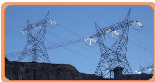
**Imagen 38 a y b.** Aisladores eléctricos para líneas de alta tensión
