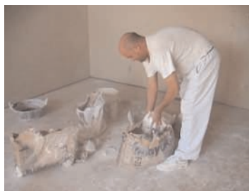
Figura 118 - Escayolista: trabajo a ras del suelo.
