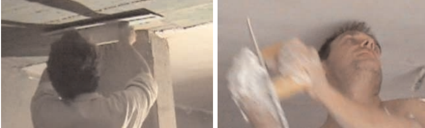
Figura 101 - Yesista: trabajo en techo.
