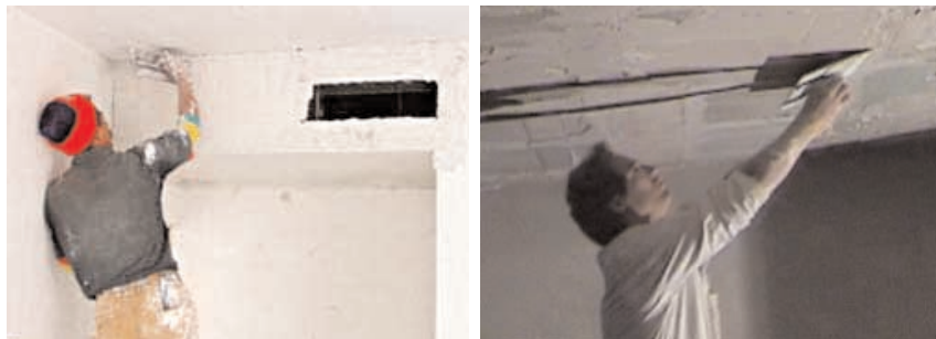
Figura 100 - Yesista: trabajo en techo.
