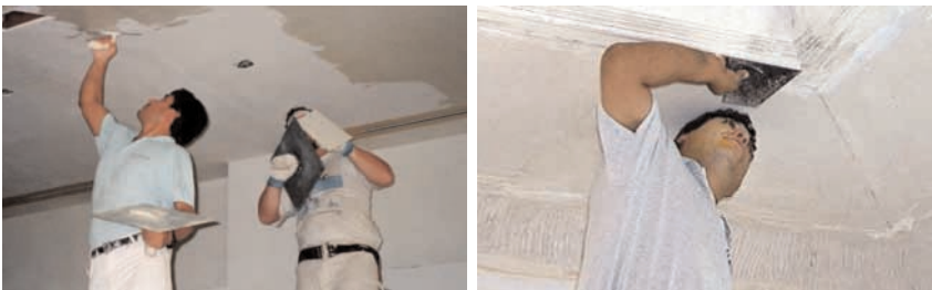
Figura 102 - Yesista: trabajo en techo.
