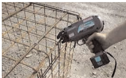
Figura 68 - Herramienta eléctrica para el atado de ferralla.
