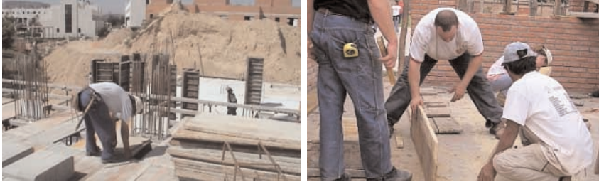
Figura 46 - Encofrador: trabajo a ras de suelo.
