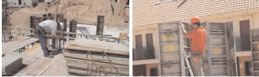
Figura 49 - Encofrador: posturas forzadas de manos.
