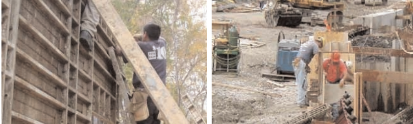
Figura 52 - Encofrador: trabajo sobre superficies irregulares.
