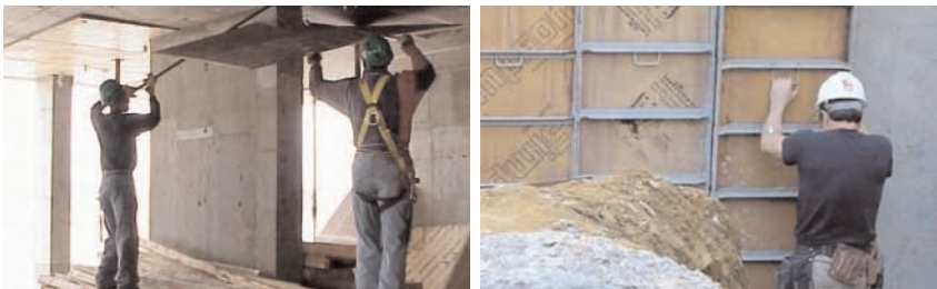
Figura 47 - Encofrador: brazos elevados (y sobre superficies inestables).
