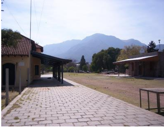
Fotografía: estación de trenes de Capillan del Monte
