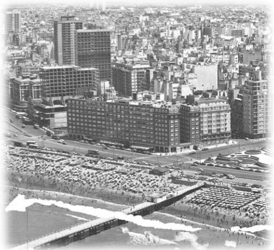
"Área de Mar del Plata en la década del 70. El Bristol Center en Construcción". Foto enviada por Roque Martínez a Fotos de Familia del Diario la Capital, publicada en fotosviejasdemardelplata.blogspot.com.ar
