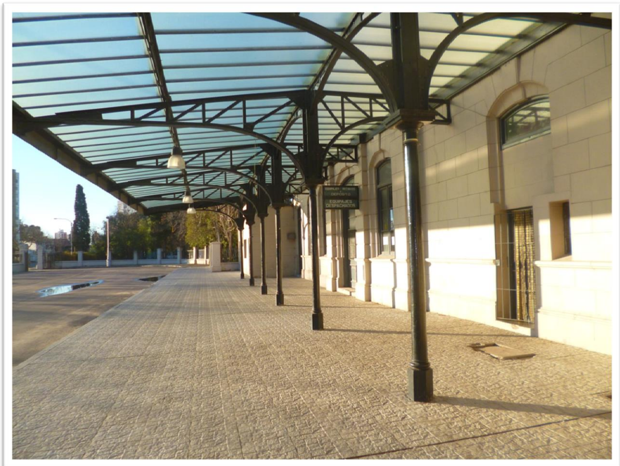
Estación de trenes de Bahía Blanca - Ferrocarril Sud.
