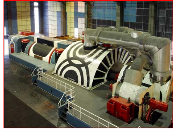
Turbina de Media y Baja Presión. Cuerpo de turbina y carcasa.
