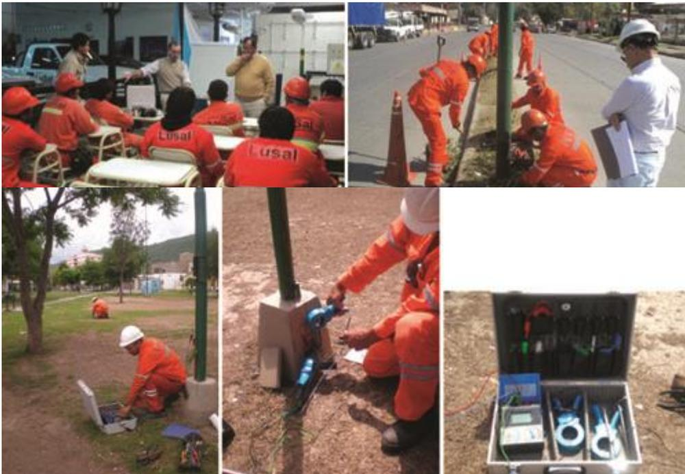
*Figura nº 42 Personal de la empresa LuSal capacitándose en el esquema de tierras TN-S, Adecuando instalaciones y realizando el mantenimiento predictivo del Alumbrad Público*
