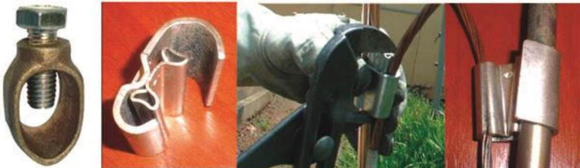
*Figura nº 32. Conector a compresión elástica, no afectado por las vibraciones y la corrosión del suelo. Las conexiones roscadas enterradas no se permiten. Si son colocadas en cajas de inspección, innecesarias en la instalación del AP, son afectadas por la vibración y la corrosión del material galvanizado o cadmiado.*
