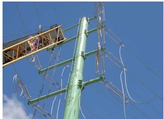
Los elementos perpendiculares al eje del poste, sobre los que se sujetan los conductores, se denominan ménsulas cuando salen del eje del poste hacia un solo lado, o cruceas cuando "cruzan" el poste en ambos sentidos.
