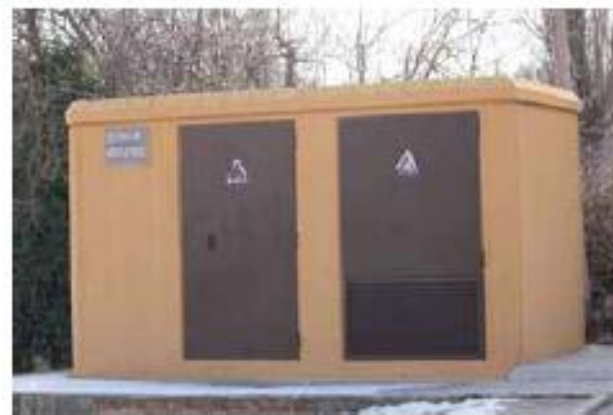
Fig. 1.26. CT prefabricado.
