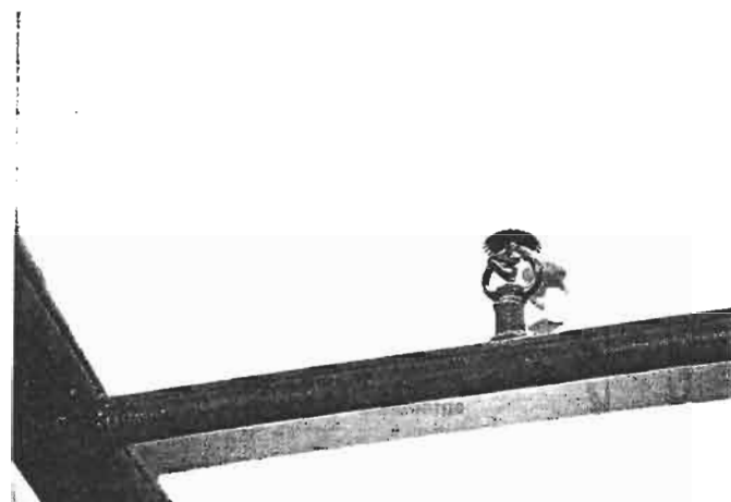
Figura 27.—Rociador automático montante.
