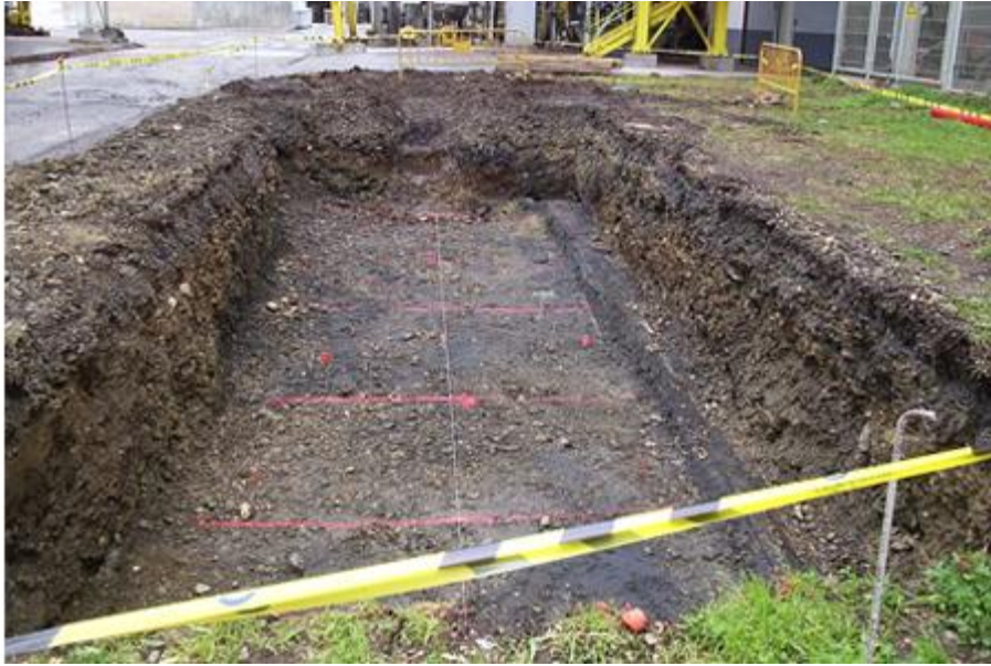
Vaciado con talud adecuado en paredes y acceso para personal excavado en pared y delimitación mediante cinta de señalización
