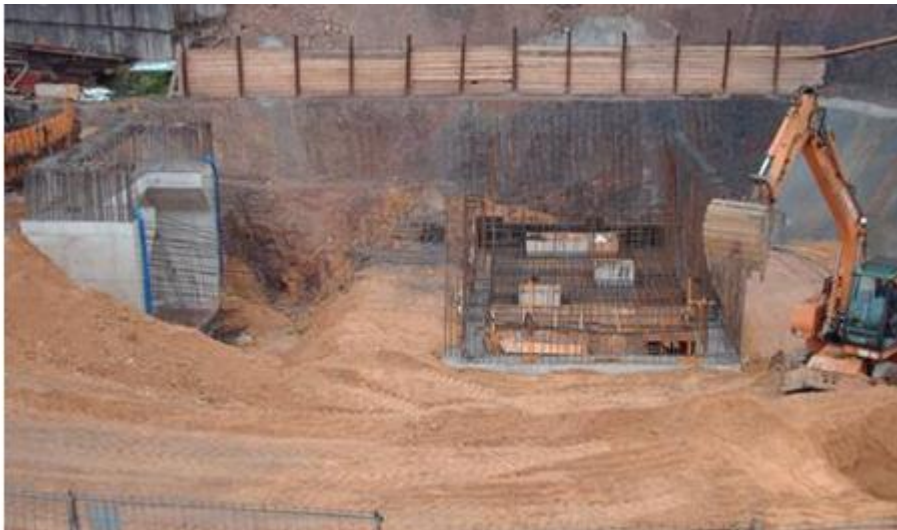
Vaciado con taludes, cierre perimetral, rampa de acceso máquinas y protección en coronación de taludes
