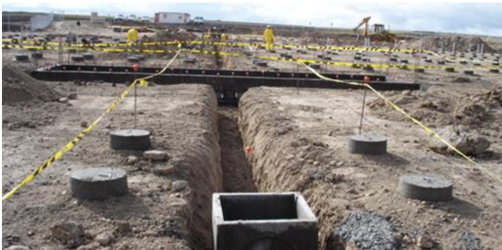
Zanjas con talud y delimitación con cinta de señalización
